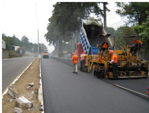
Figura 6: Tramo de carpeta de asfalto con agregado virgen 20013
